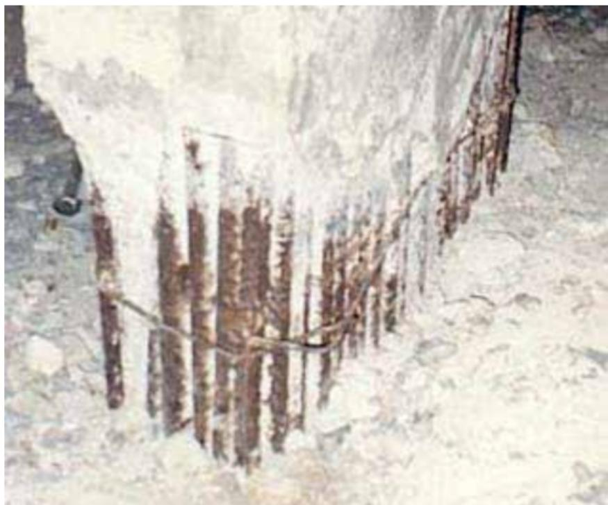
Alta densidade de armadura com cobrimento insuficiente provocando corrosão generalizada e expansão da seção das armaduras com posterior rompimento dos estribos. (Jefferson Maia Lima)
