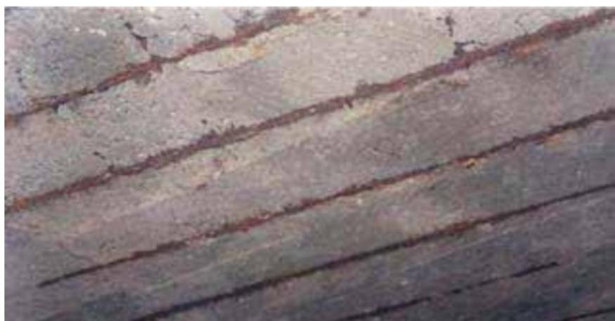
Laje executada sem o mínimo de cobrimento para proteção da armadura que coincidiu com as juntas das fôrmas provocando corrosão generalizada e expansão da seção das armaduras. (José R. S. Pacha)
