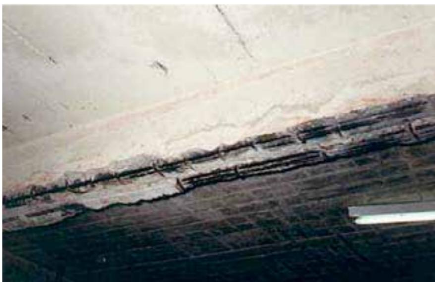
Alta densidade de armadura na base da viga com cobertura insuficiente e, infiltração pela junta de dilatação provocando corrosão generalizada e expansão da seção das armaduras. (Jefferson Maia Lima)
