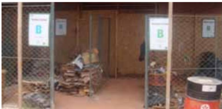
Figura 8 - Segregação de RCD no canteiro de obras.
