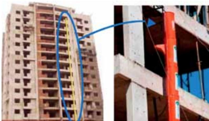
Figura 11 – Tubo condutor vertical de entulho.
