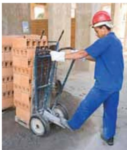
Figura 5 - Transporte adequado de blocos cerâmicos.
